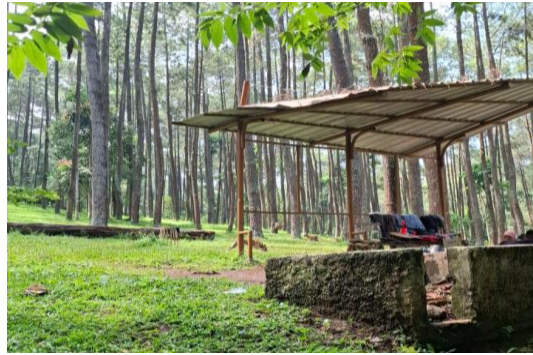
Gambar 5. 31 Kondisi Eksisting Gazebo 3
