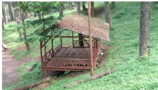
Gambar 5. 30 Kondisi Eksisting Gazebo 2
