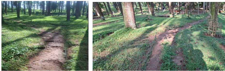
Gambar 5. 22 Kondisi Eksisting Saluran Air
