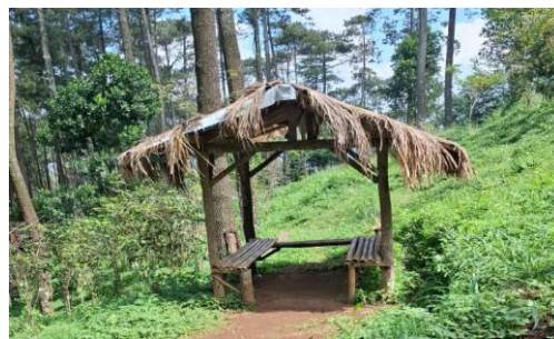
Gambar 5. 32 Kondisi Eksisting Gazebo 4
