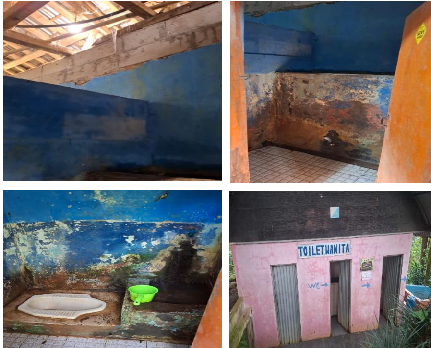
Gambar 5. 3 Kondisi Eksisting Toilet Pria & Wanita
