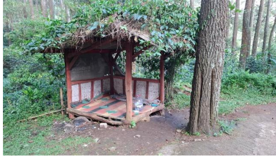
Gambar 5. 29 Kondisi Eksisting Gazebo 1
