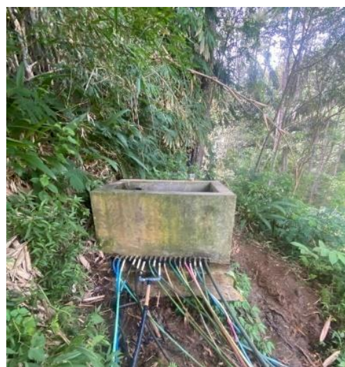
Gambar 5. 2 Bak Penampung (Eksisting)
