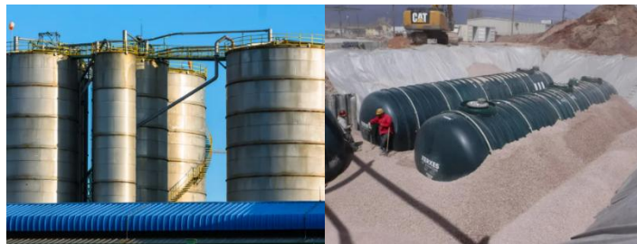
Gambar 6. Perbedaan Aboveground tank dan underground tank
