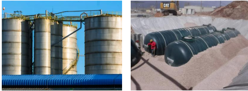
Gambar 1. Perbedaan aboveground tank dan underground tank
