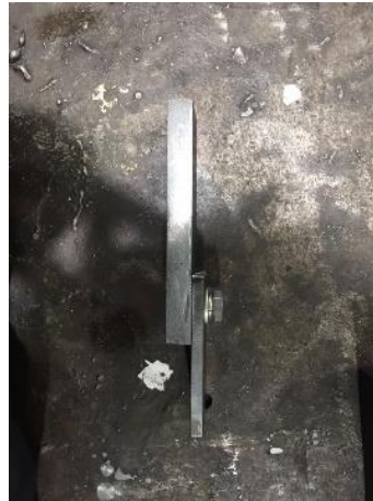
Gambar 16. Pemasangan baut stainless steel AISI 304
