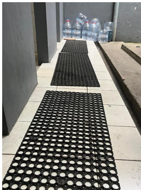
Gambar IV.6 Area Depan Toilet
