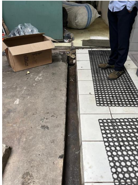
Gambar IV.7 Saluran Air Depan Toilet
