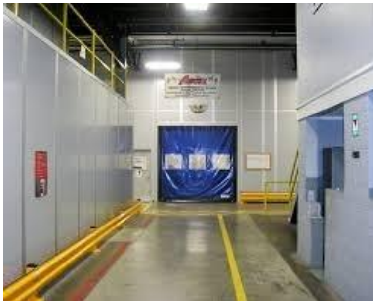
Gambar II.6 Proteksi Kebakaran Pasif Dinding Pemisah
