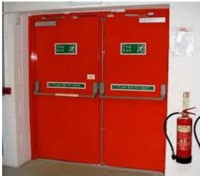
Gambar II.7 Proteksi Kebakaran Pasif Pintu Tahan Api
