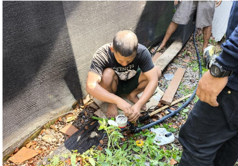
Gambar 5.2 Proses Penyambungan Saluran Air Baru
