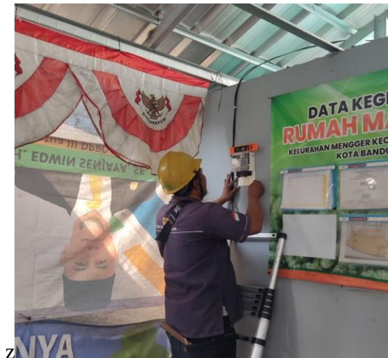
Gambar 5.1 Proses Pemasangan Aliran Listrik Baru
