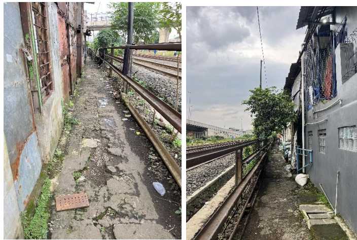
Gambar 4. 8 Kondisi Jalan Di Sempadan Rel Kereta RW 04
