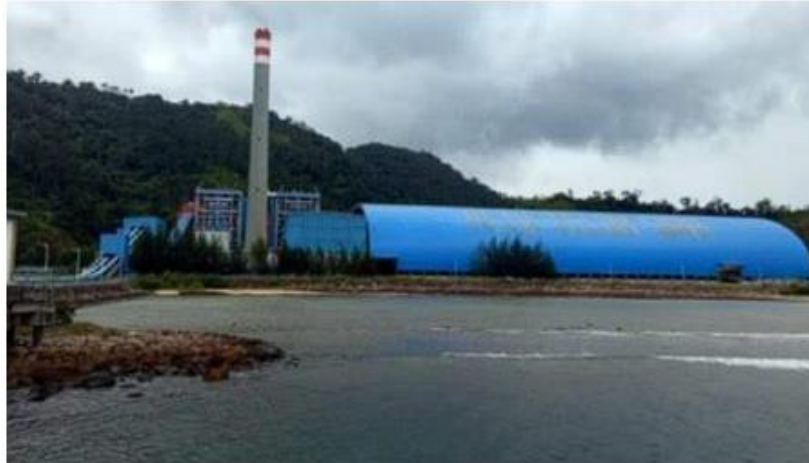
Gambar 1. PLTU Teluk Sirih 112 MW [9]
