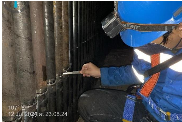
Gambar 42. Proses Pengukuran GAP
