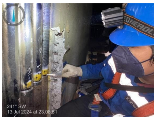
Gambar 65. Mengukur GAP
