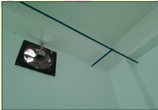
Gambar 11. Kondisi Dinding pada Ruang Produksi
