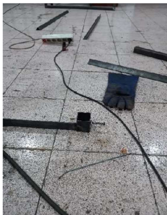
Proses pemotongan material plywood sebagai dudukan lampu dan penutup rangka bagian atas
