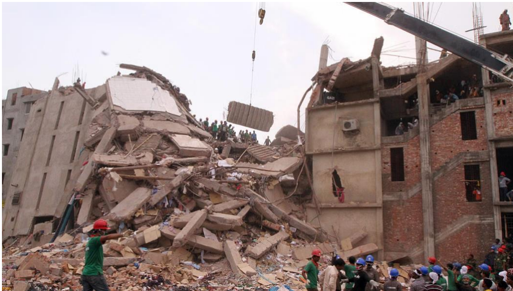
Gambar 2. Keruntuhan Bangunan Rana Plaza
