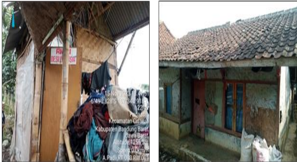
Gambar 1. 1 Rumah Tidak Layak Huni
