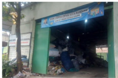
a. Pintu Masuk Gudang
