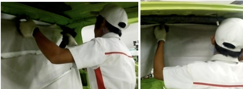
Gambar L. 4 Pemasangan Head Lining
