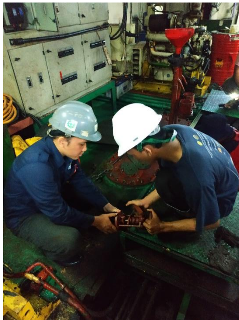
Gambar 24. Pengecekan Kembali Valve
