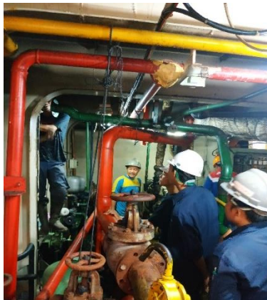
Gambar 17. Pengenalan kode warna pipa
