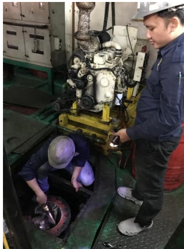
Gambar 21. Pembersihan Base Filter
