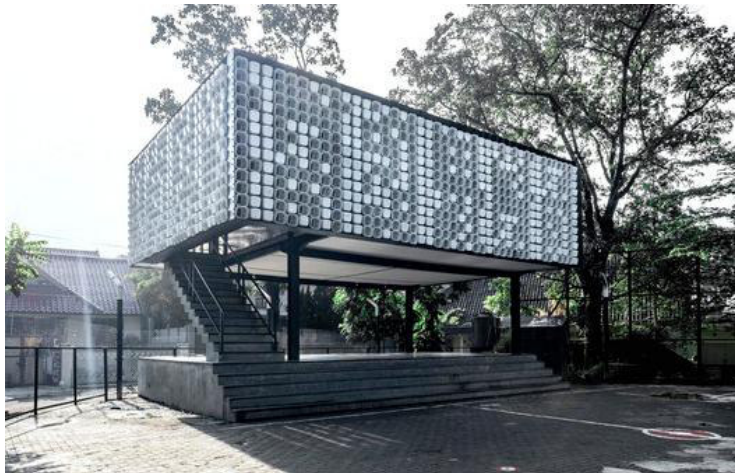
Gambar 2 Microlibrary Kota Bandung (Sumber : Dokumentasi SHAU Architect)
