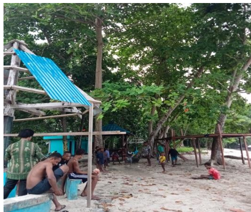
Pembuatan fasilitas wisata pantai Bakaro
