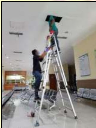
Pengambilan Sampel Filter AC (swab) Sebelum Pembersihan
