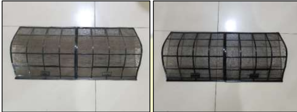
Gambar 4.19 Filter AC Sebelum (Kiri) dan Sesudah (Kanan) Pembersihan
