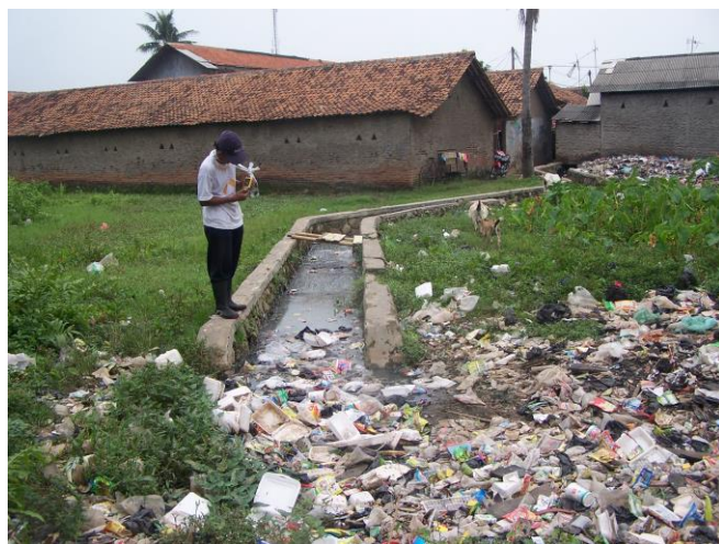
Gambar 5.24 Saluran Inlet Situ Cangkring Di Dekat Permukiman
