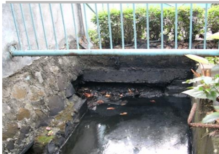
Gambar 5.26 Saluran Outlet Situ Cangkring Di Dalam Industri
