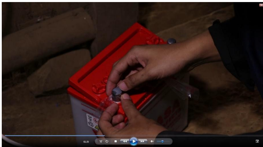
Gambar 4.14 Pemasangan accu untuk lampu LIMAR
