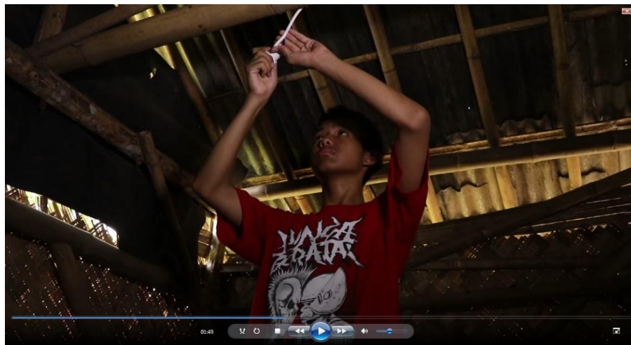
Gambar 4.13 Pemasangan lampu LIMAR di salah satu rumah warga
