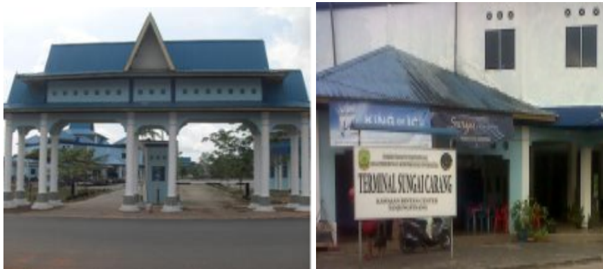
Gambar 3.12 Kondisi Eksisting Terminal Sungai Carang
