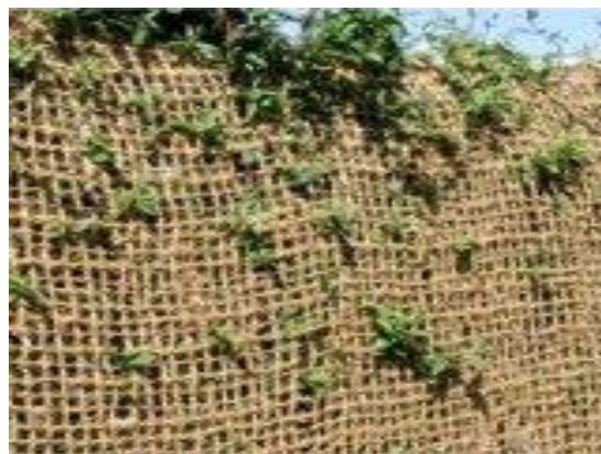
Gambar 2.8 langkah pemasangan Cocomesh.
