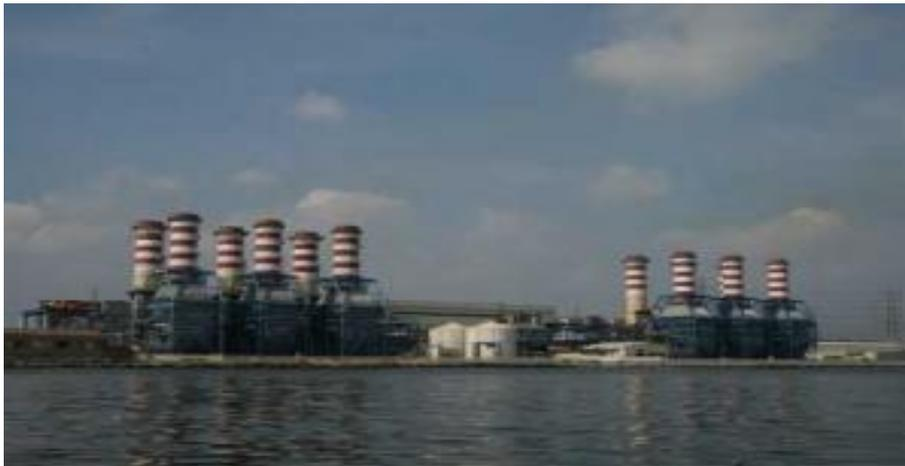
(Gambar L-I – UBP Priok, Kapasitas Terpasang : 1.248 MW, Jenis Pembangkit : PLTU, PLTGU, PLTG, PLTD)
