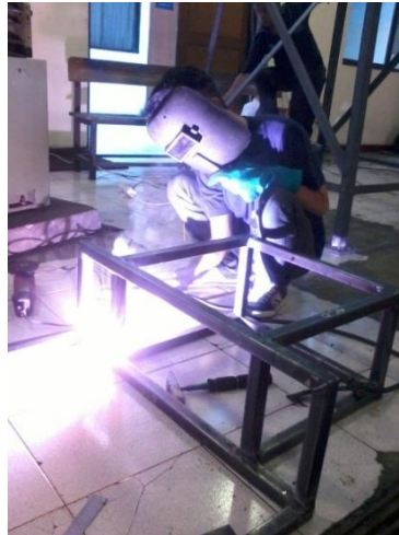
Gambar 5. 9 pengelasan rangka bagian depan
