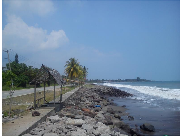
Gambar 4.39 Bangunan Tembok Penahan Ombak (Sea-Wall) di Desa Caringin
