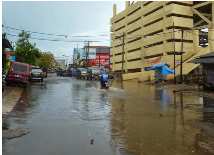
Gambar 4.41 Gedung Pasar Semi-Modern yang Berfungsi Sebagai Shelter di Desa Kalanganyar
