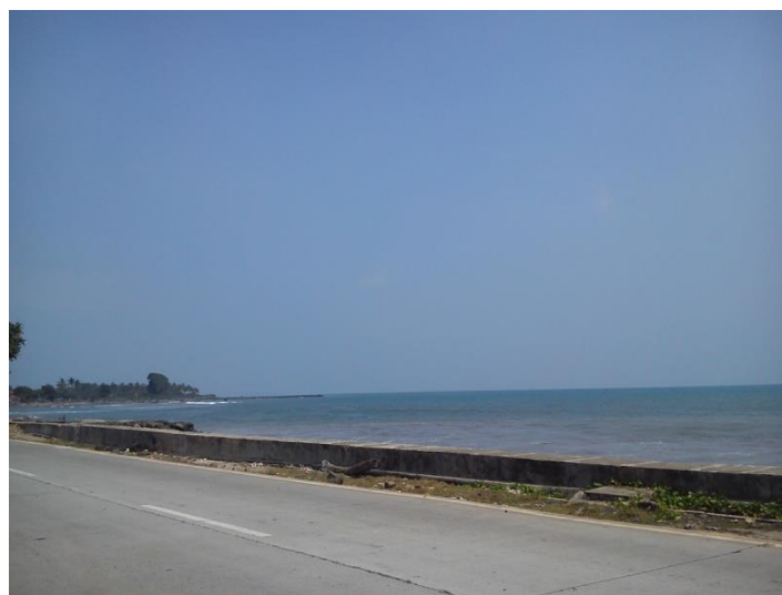
Gambar 4.40 Bangunan Tembok Penahan Ombak (Sea-Wall) di Desa Teluk
