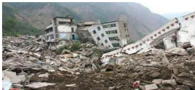
Gambar 2.4 kerusakan lingkungan akibat gempa bumi ( http://aisyahvelya.blogspot.co.id/2013/11/kerusakan-lingkungan-faktor-alam.html )
